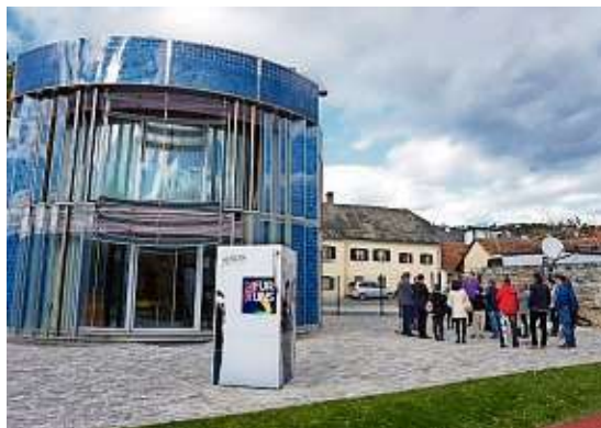
Ein Haus, das sich dreht und Energie liefert
